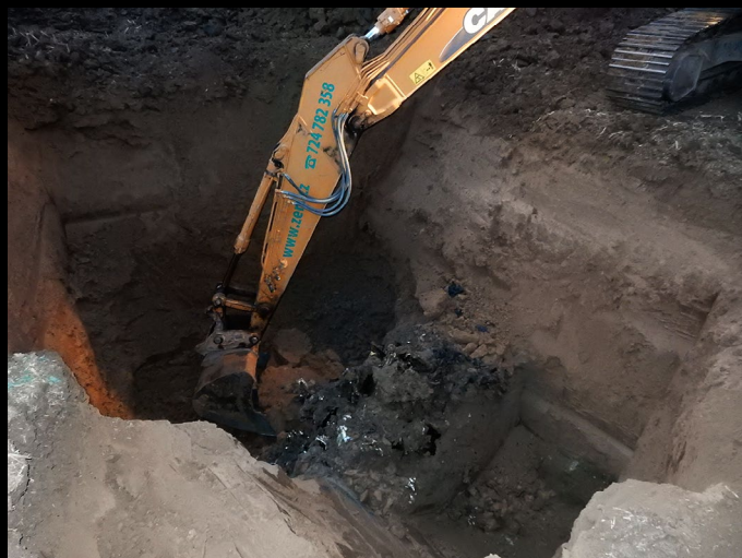
Jsme u motoru, těsně před zalitím vodou
