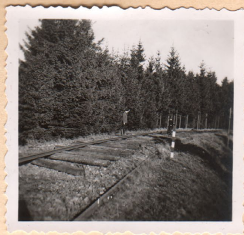
Mit Reißern aufgerissene Eisenbahnstrecke Gärten - Schönlinde
