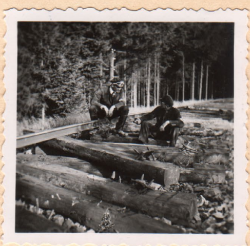
Sämtliche Schwellen wurden herausgerissen
