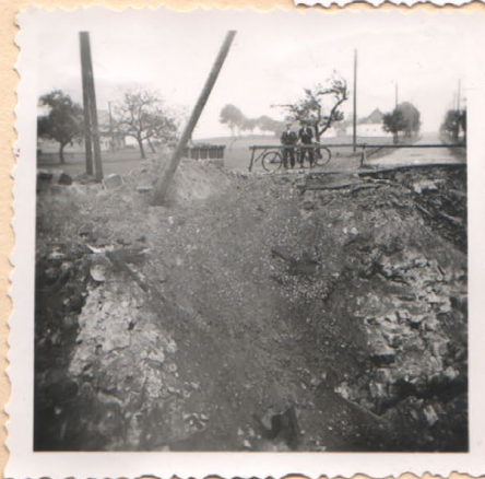
Teilansicht der Sprengung
