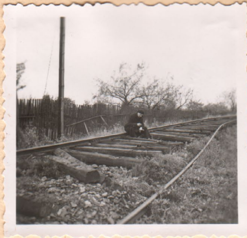
Mit Reißern aufgerissene Eisenbahnstrecke Gärten - Schönlinde
