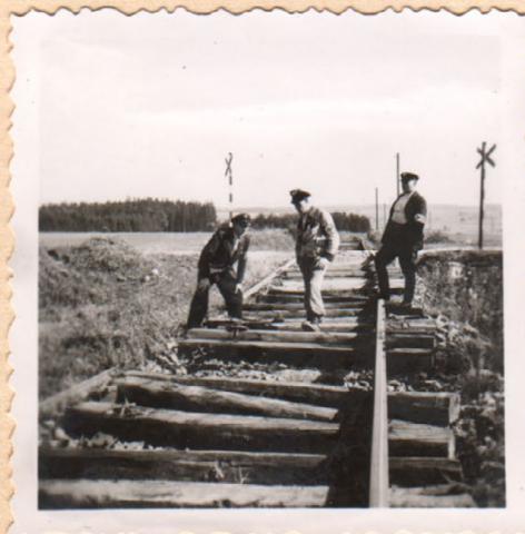
Sämtliche Schwellen wurden herausgerissen
